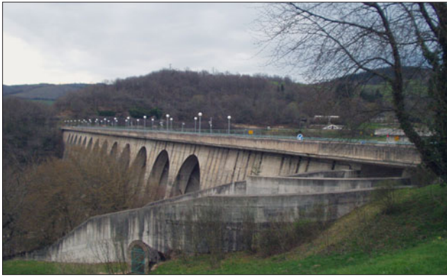
a - le barrage de Pannesière-Chaumard
